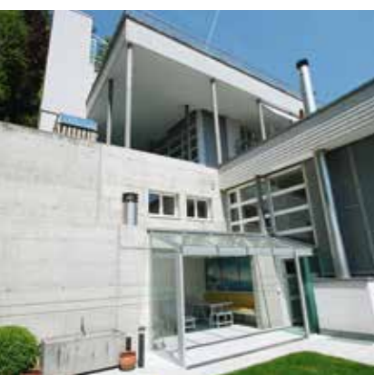
Vue extérieure du jardin, avec le nouveau jardin d'hiver, la fenêtre du sauna et la tour d'ascenseur
