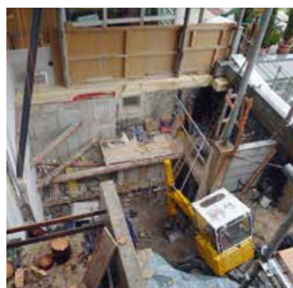
Travaux de terrassement pour l'ascenseur au niveau de la terrasse de la maison supérieure avec la nouvelle véranda, la fenêtre du sauna et la tour d'ascenseur
